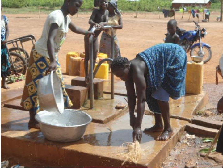
Entretien d'un point d'eau à Kérou
